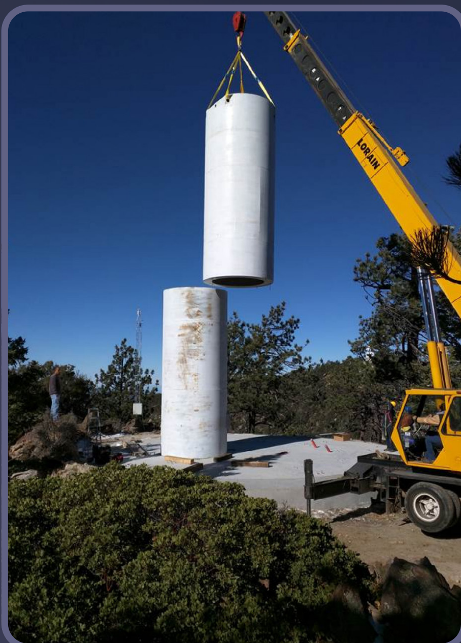
左：兩個高 12 米的望遠鏡基座吊掛。右：外殼骨架施工。© 黃鍾凱 / 中研院天文所
